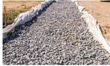
Exemple de structure réservoir en cours de construction
